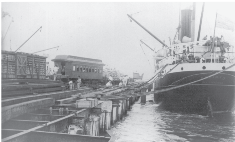
Foto N.º 3. El puerto de Puntarenas. En la gráfica se observa la intensa actividad portuaria que le caracterizó. Se hizo necesario que las líneas del ferrocarril llegaran hasta el punto extremo del muelle para facilitar la carga y descarga de los productos.
