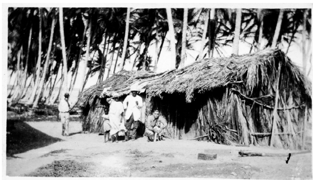
Casa de paja, conocida localmente como 'bohío'. Los 'bohíos' se consideran el legado de los nativos taínos y fueron la residencia típica de la mayoría de los dominicanos antes de la llegada del huracán San Zenón en 1930. Fuente: USMC, 1922, Santo Domingo, Dominican Republic 20 of 26. Autor: Richard from USA, CC BY 2.0
