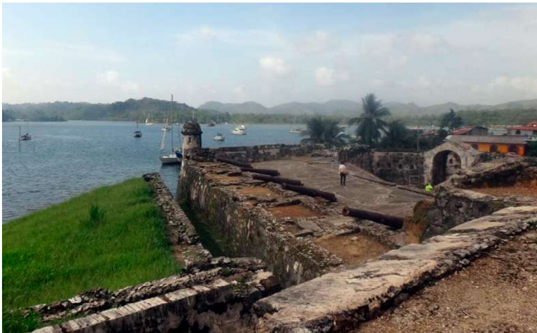
Fuertes de Portobelo. Fotos Nayibe Gutiérrez M.
