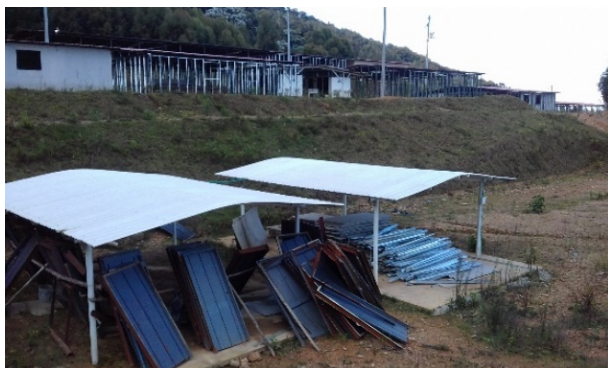
Foto 8. Casetas inacabadas en la parte superior del campamento, La Elvira.
