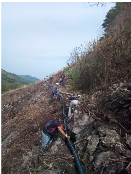
Foto 4. Obra colectiva de tubería.
