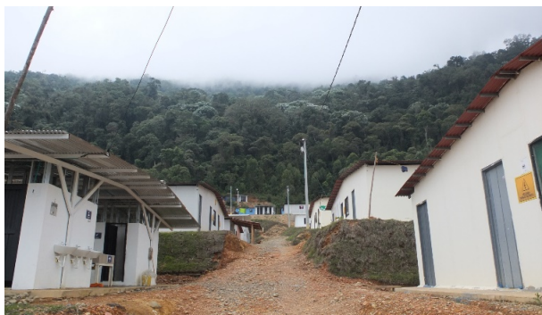
Foto 7. Casetas en terreno empinado en la parte superior del campamento, La Elvira.
